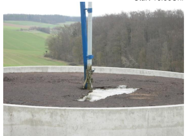
Güllebehälter mit \varnothing 10,8 m und 4 m Höhe (ca. 350m 3 ) Start 16:38Uhr
